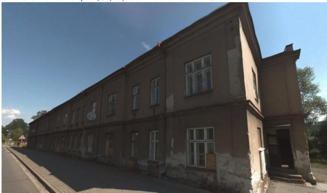
Obrázek 9 Blok domů čp: 31, 32, 35, 40 a 41 v lokalitě Malé Poříčí
